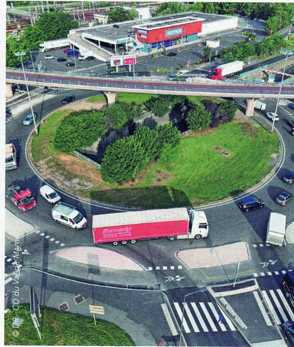
Vue aérienne du giratoire à la hollandaise de Créteil.
